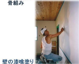
壁の漆喰塗り
